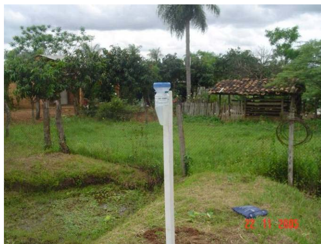
Pluviómetro instalado en uno de los puntos de monitoreo, correspondiente a Capiatá
