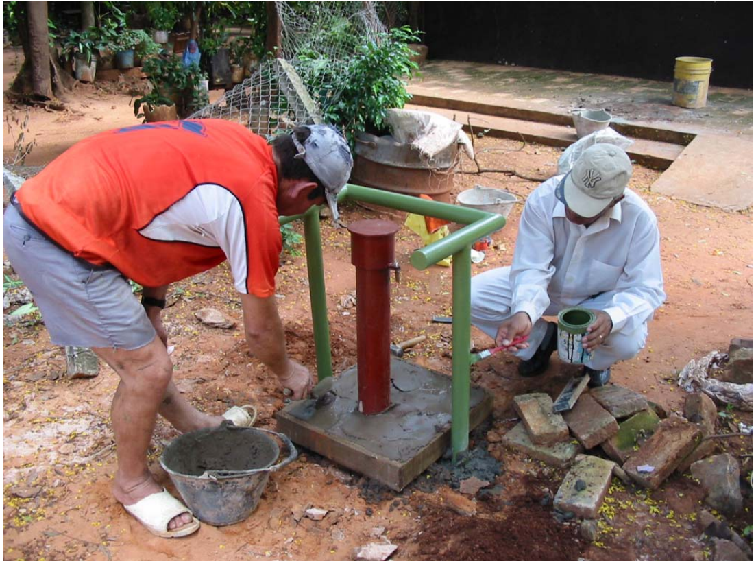
Colocación Protección Pozo Colegio Margarita Beia
