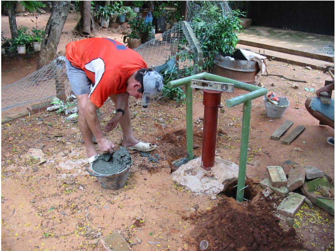
Colocación Protección Pozo Colegio Margarita Beia
