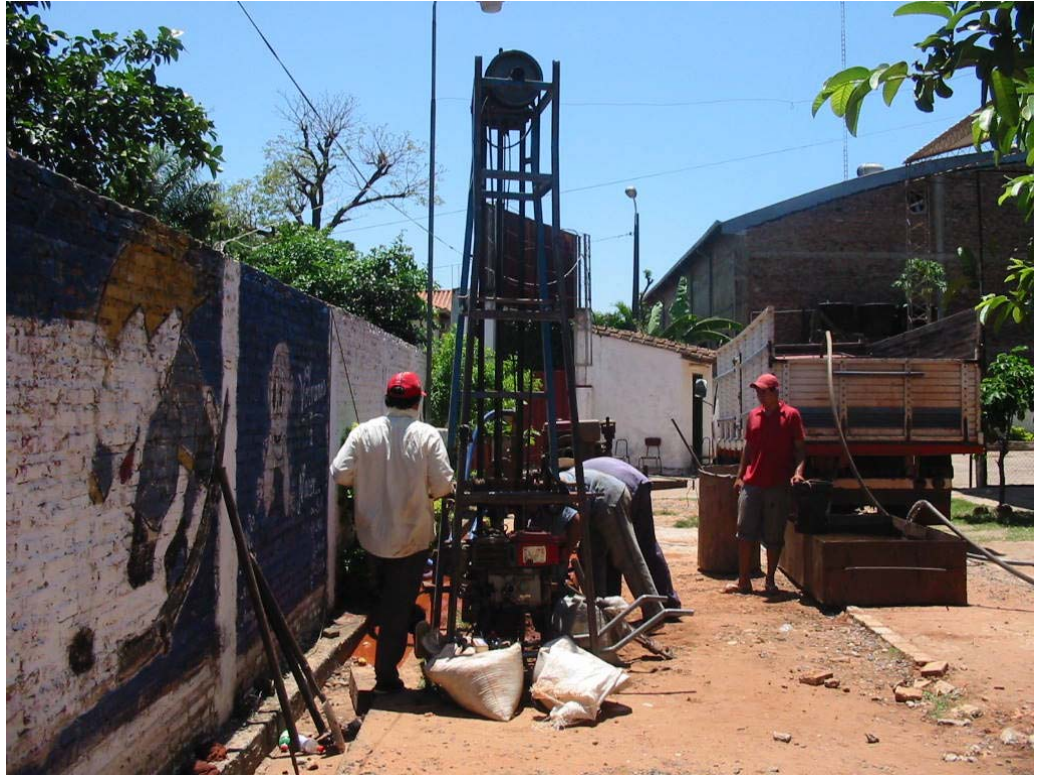
Perforación de Pozo Colegio San Lorenzo
