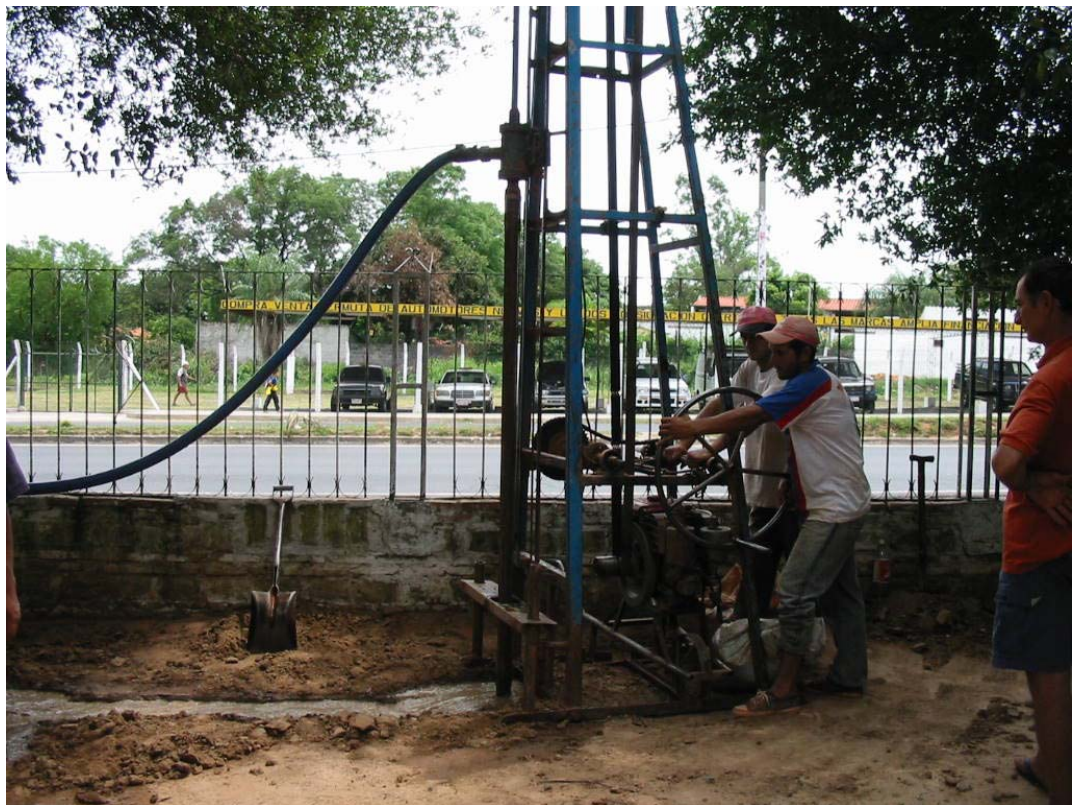
Perforación de Pozo Colegio Julio Correa
