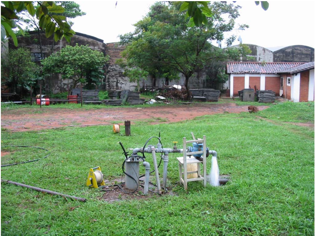
Fig. 8: Fotos Ensayo de Bombeo SENASA
