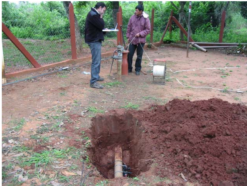
Fig. 20: Fotos Ensayo de Bombeo Posta Ybyraro
