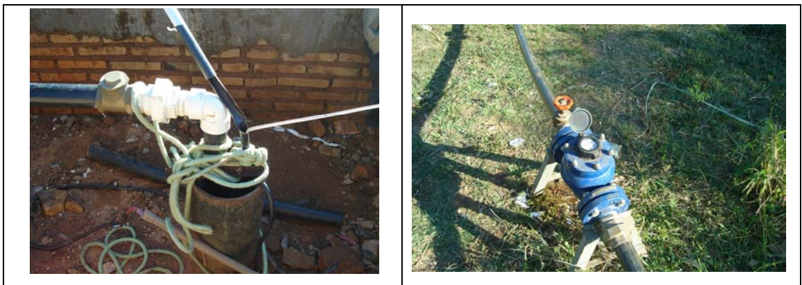
Fig. 31: Fotos Ensayo de Bombeo Limpio
