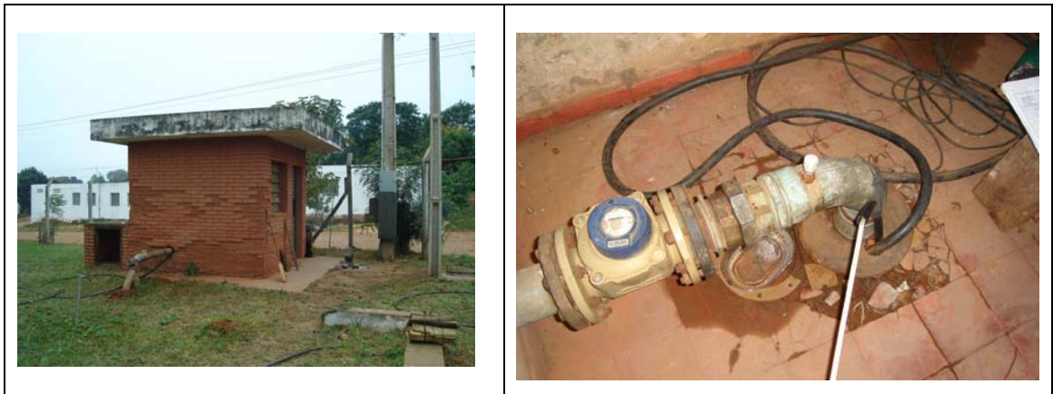
Fig. 42: Fotos Ensayo de Bombeo ESSAP Lambare
