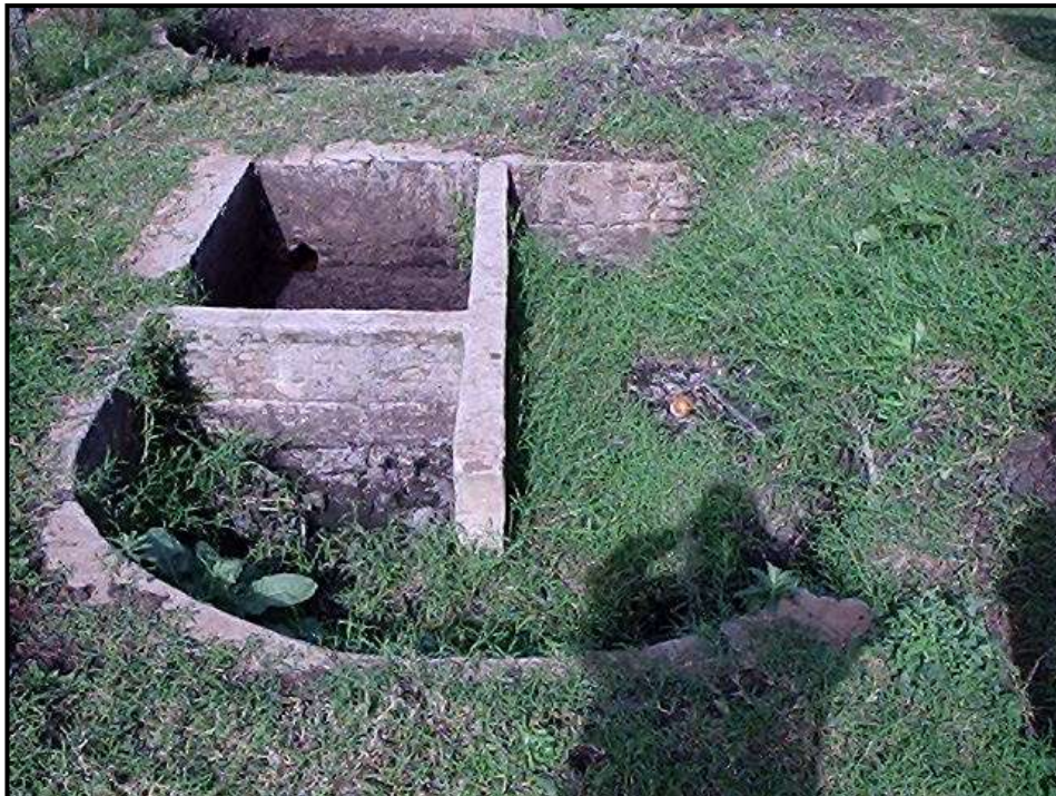
San Juan Bautista – Matadero Municipal, piletas de separación de sólidos y líquidos
