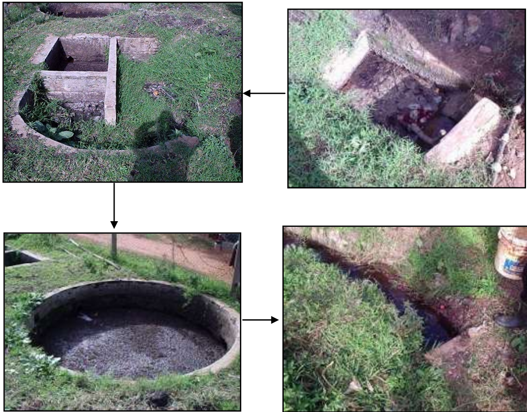
Fig. 123 – San Juan – Descarga de efluentes del Matadero Municipal
