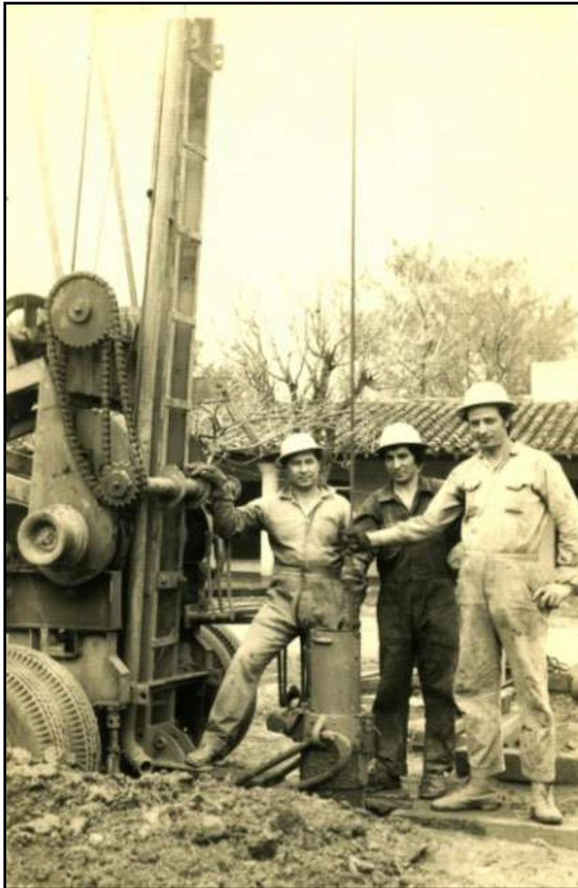
Itauguá – Perforación del Pozo 1 de la Junta de Saneamiento, predio de la iglesia. Construido por SENASA. Perforistas: Faustino Franco, Gregorio Bazán – Fermín Cristaldo – Año 1975
