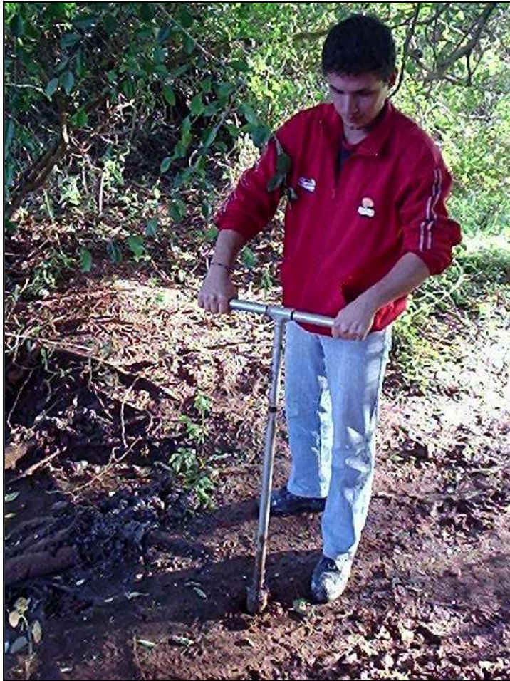
Itauguá – Ejecución del Sondeo Mecánico N° 1
